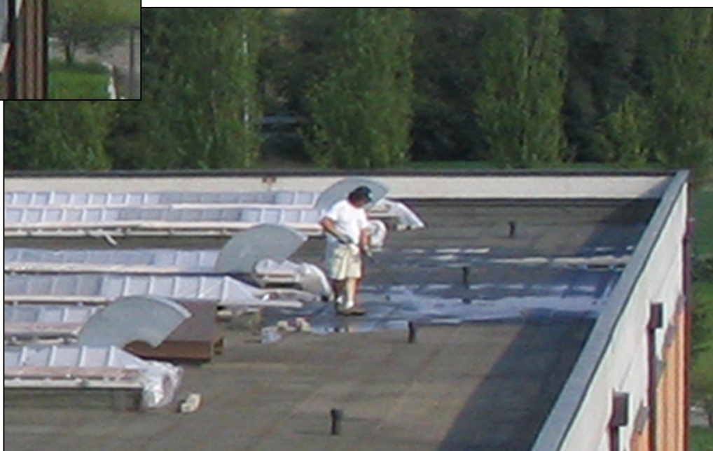
Preparazione della superficie (pulitura e lavaggio)
